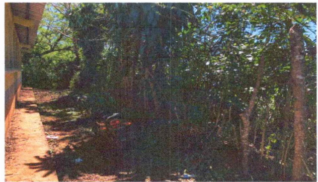
Foto 4: Circulación parte Oeste
